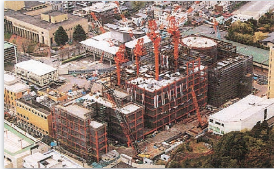
栃木県庁新築工事
